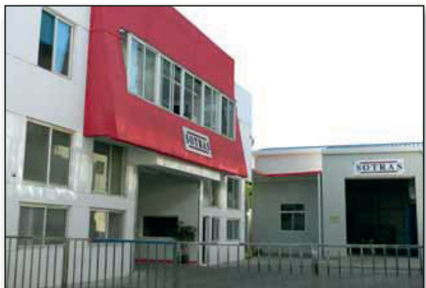
SOTRAS CHINA WAREHOUSE
